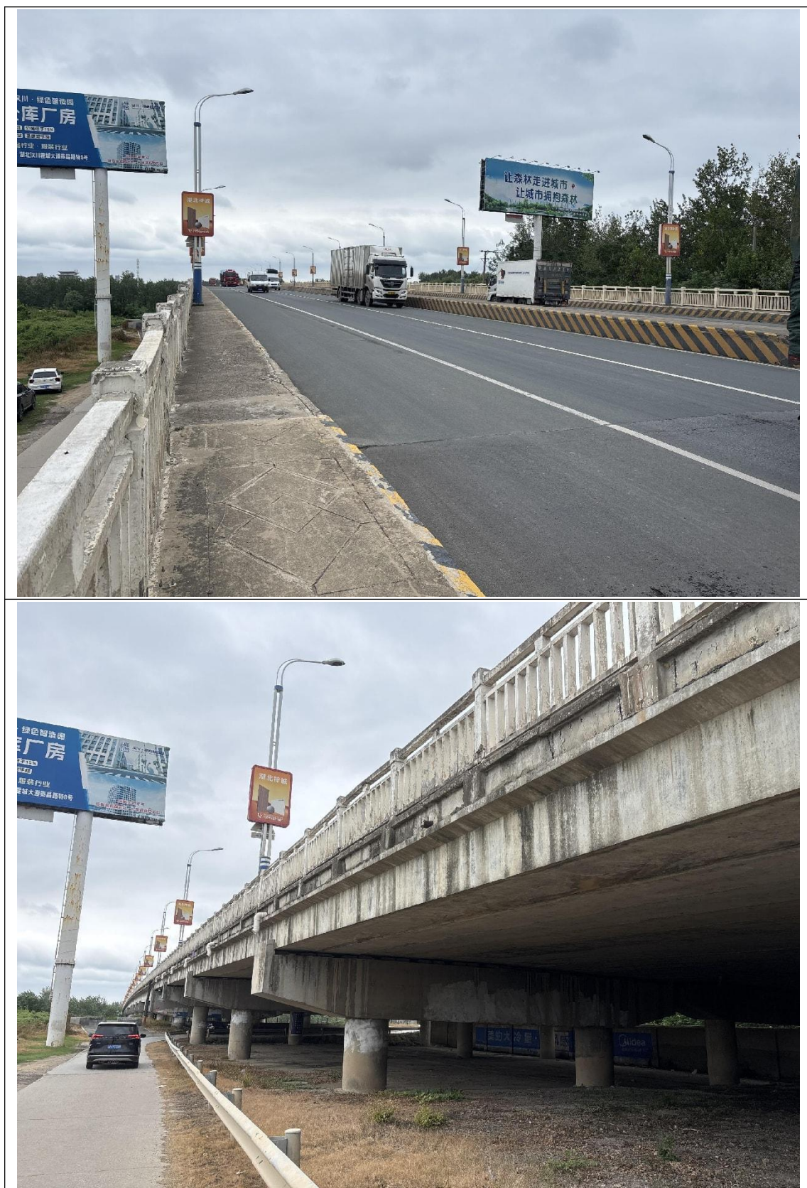
图 4.2-8 汉北河大桥现场调查情况
