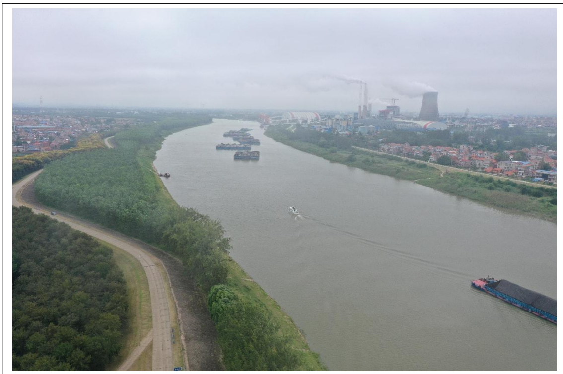
图 4.2-6 汉江河堤现场调查情况
