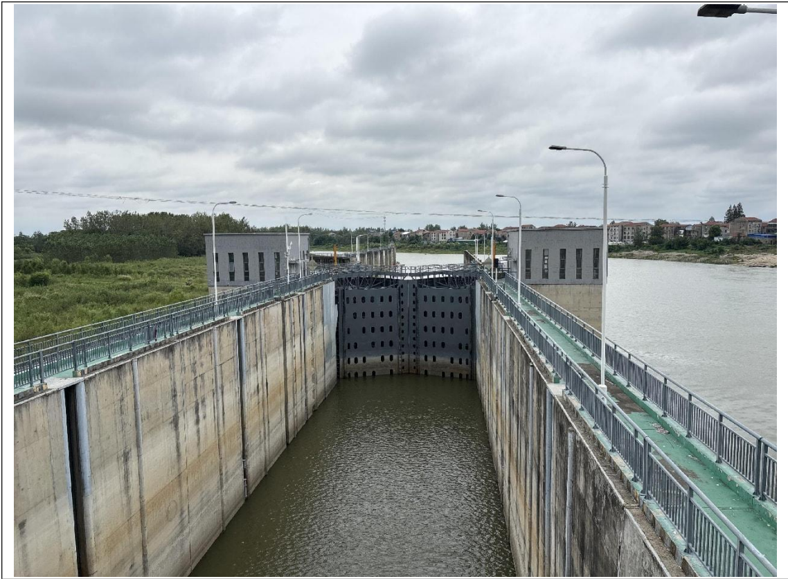
图 4.2-13 新沟闸现场调查情况
