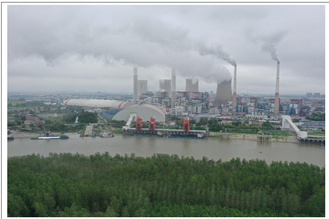
图 4.2-2 汉川热电厂码头现场调查情况
