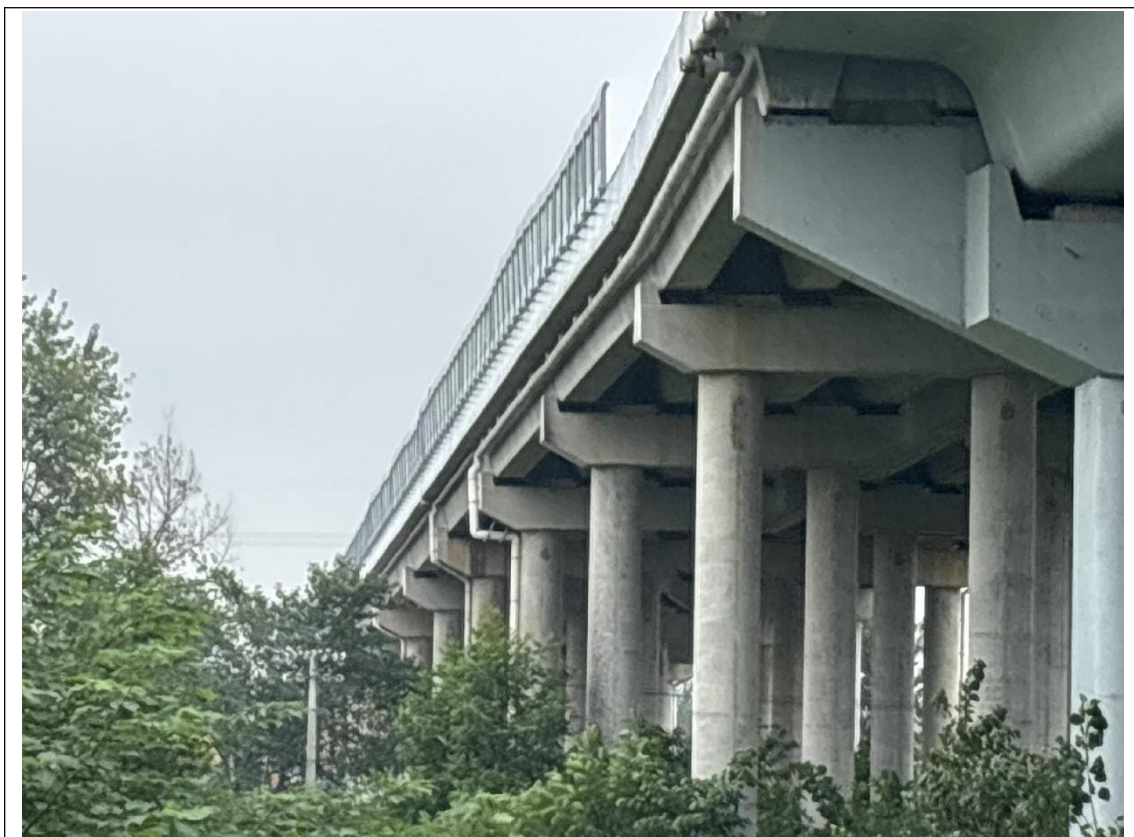
图 4.2-5 汉川汉江二桥现场调查情况
