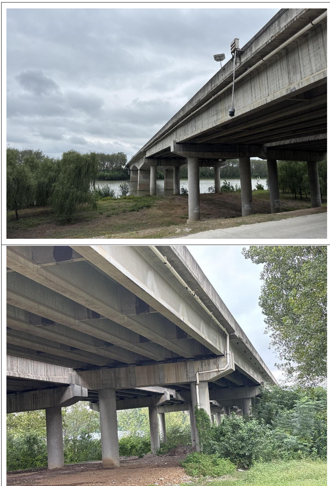
图 4.2-9 汉北河一号大桥现场调查情况
